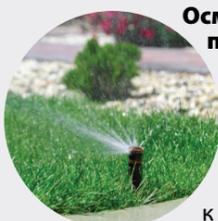
**Осмотрите свою систему полива** и проверьте, нет ли сломанных или отсутствующих спринклеров. Проверьте точки соединения исправить утечки. Всего лишь один сломанный спринклер может привести к потере до 1000 галлонов воды в неделю.
